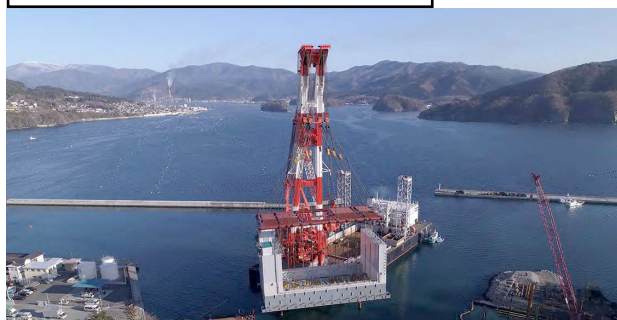
起重機船による水門の据付状況
