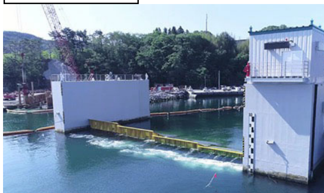
水門の試運転状況
